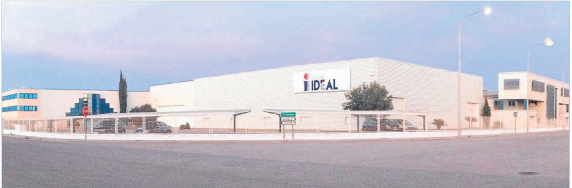
Bombas Ideal, empresa íntegramente valenciana, fijó su sede central en el Polígono del Mediterráneo en 1993. B. I.
